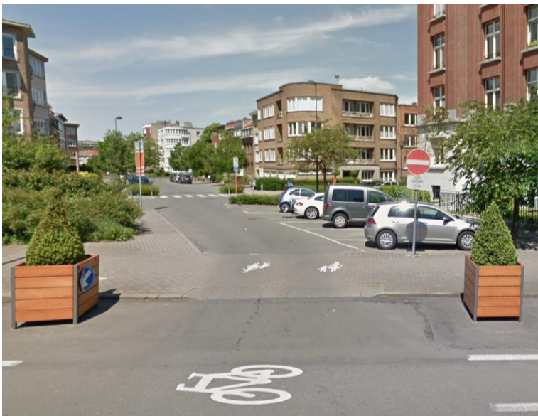
Trottoir traversant entre l'avenue des Cerisiers et l'avenue de Mars à Woluwe-Saint-Lambert (Google StreetView, 2017)
