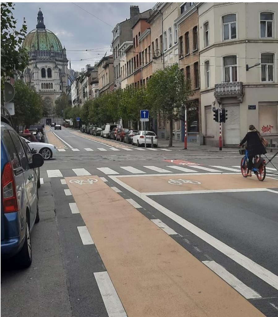
Koninklijke Sinte-Mariastraat (Schaarbeek): door in de straat eenrichtingsverkeer in te voeren, werd er ruimte vrijgemaakt om comfortabele fietspaden aan te leggen
