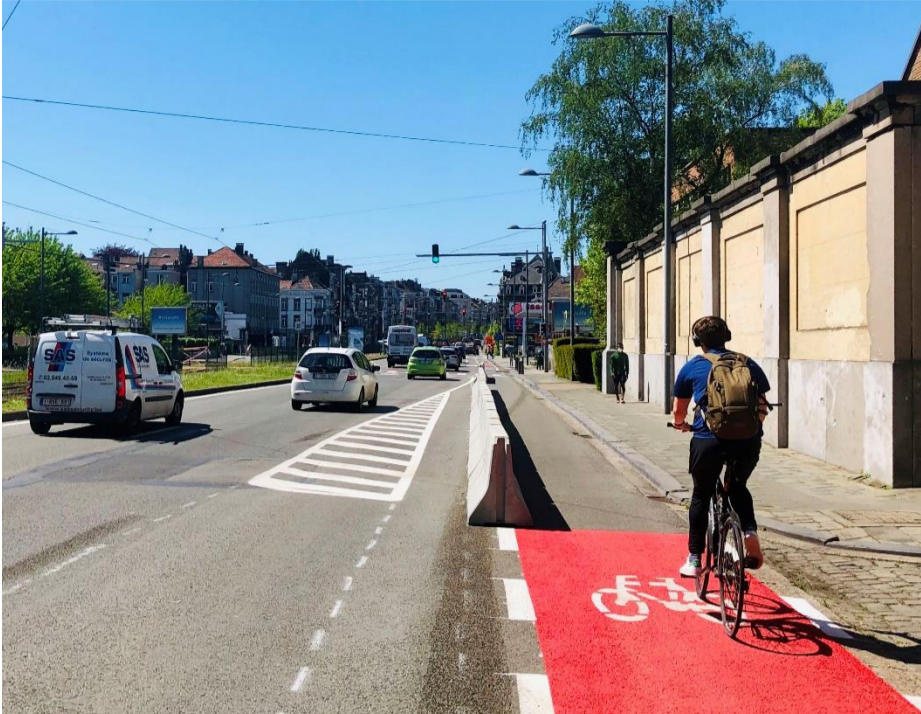
Aanleg van een fietspad op de Generaal Jacqueslaan
