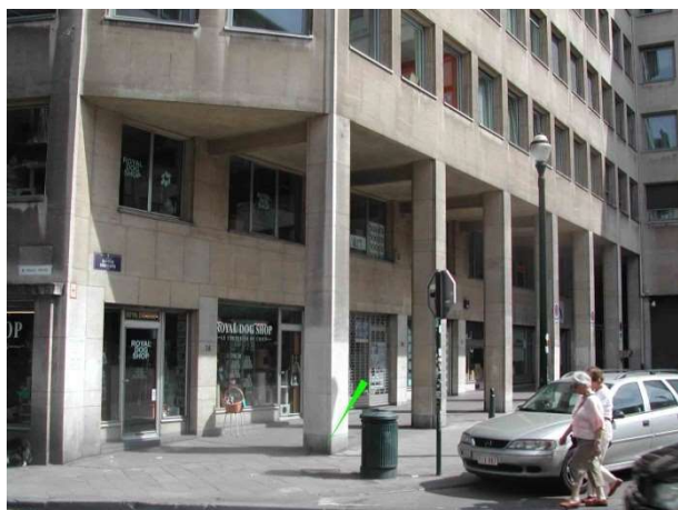
De pijlers waarvan één van de afmetingen kleiner is dan of gelijk aan 1 m worden opgenomen in de hartlijn en voorgesteld door middel van georiënteerde punten
