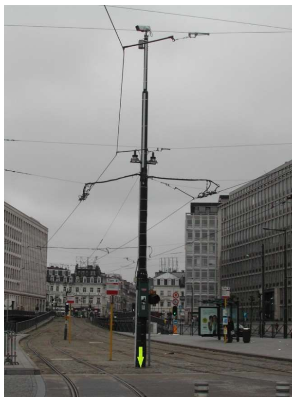
De bovenleidingpalen worden voorgesteld in de laag « CR53P » door middel van het symbool « CR5301P ».
