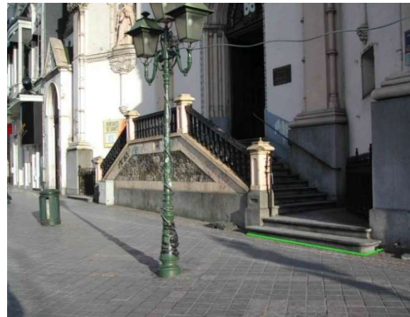
Toegangstrap naar een gebouw waarvan de op het openbaar domein ingenomen grondoppervlakte groter is dan 25 cm.
