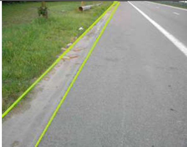
De buitenrand van de rijbaan die overeenstemt met de buitenrand van een watergreppel (afvoergeul), wordt voorgesteld in de laag « BR0117L ». De twee zijden van de watergreppel (afvoergeul) worden opgenomen.
