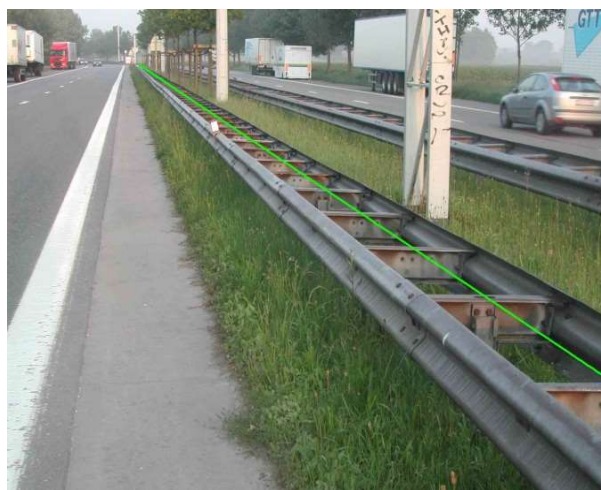
De vangrails langs wegen worden in de hartlijn (as) van hun verticale steunen opgenomen en voorgesteld in de laag « CR50L ».
