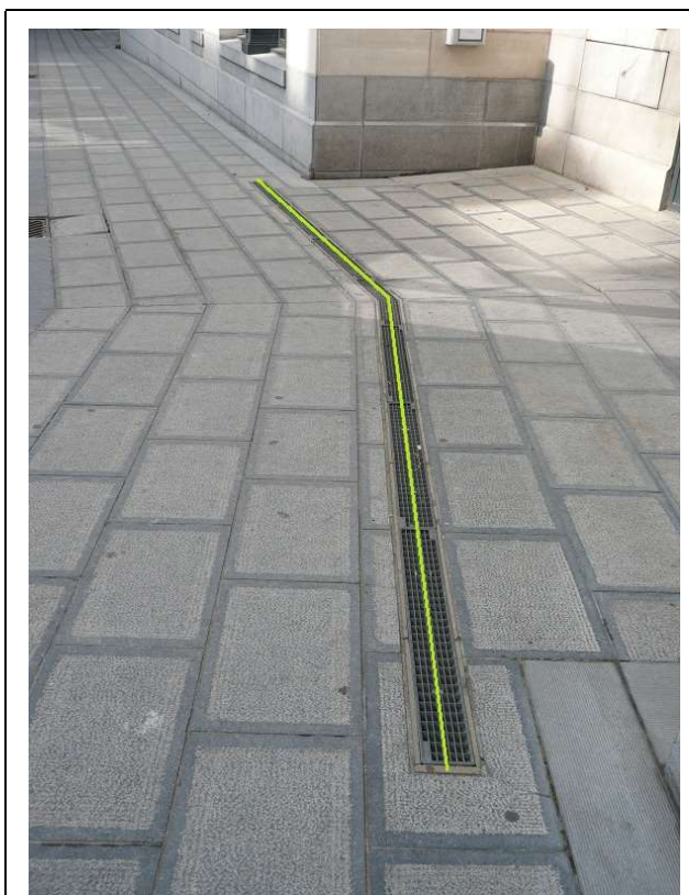
De straatgoten met een breedte < 50 cm worden in de hartlijn (as) opgenomen en voorgesteld in de laag « CR6206L ».
