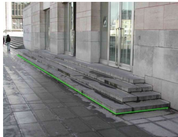
Toegangstrap naar een gebouw waarvan de op het openbaar domein ingenomen grondoppervlakte groter is dan 25 cm.
