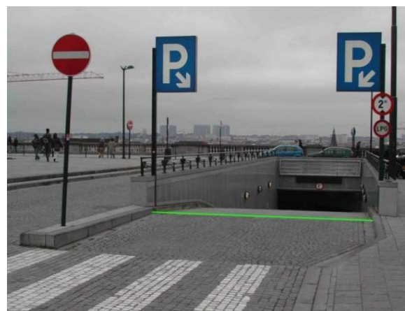
De lijn die het bovenste uiteinde van de toegangshelling naar een parkeerterrein markeert, wordt opgenomen.
