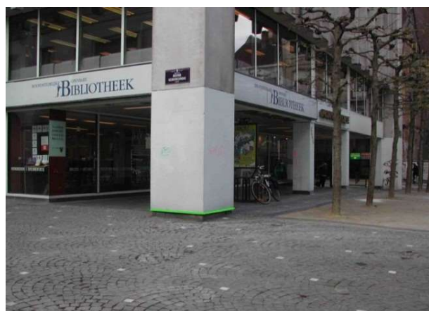
Pijlers waarvan één van de afmetingen groter is dan 1 m worden opgenomen en op ware grootte voorgesteld
