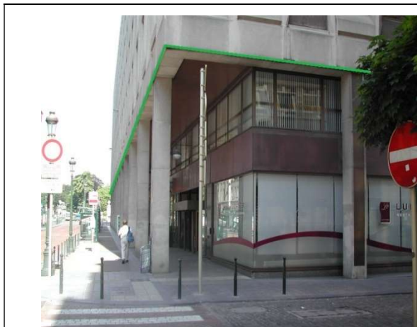
De uitkragende of vrijdragende gebouwdelen met pijlers worden altijd opgenomen en voorgesteld in de laag « BB1201L »
