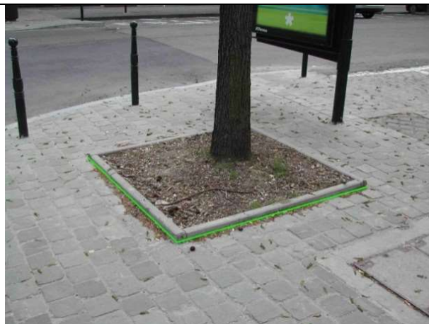
De in de trottoirs aangebrachte uitsparingen die groter zijn dan 1 m 2 worden voorgesteld in de laag « BR0104L »
