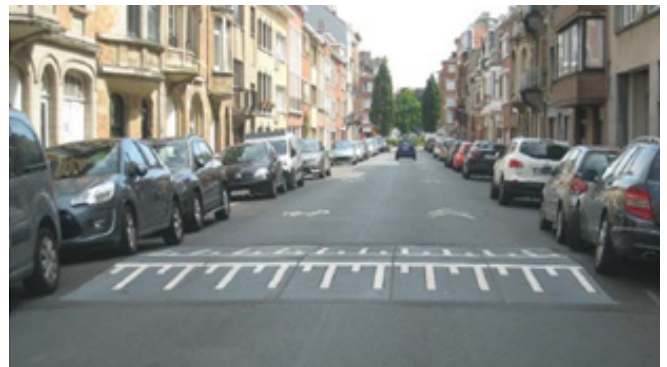
Figure 4 : Marquage en peigne sur les rampes
