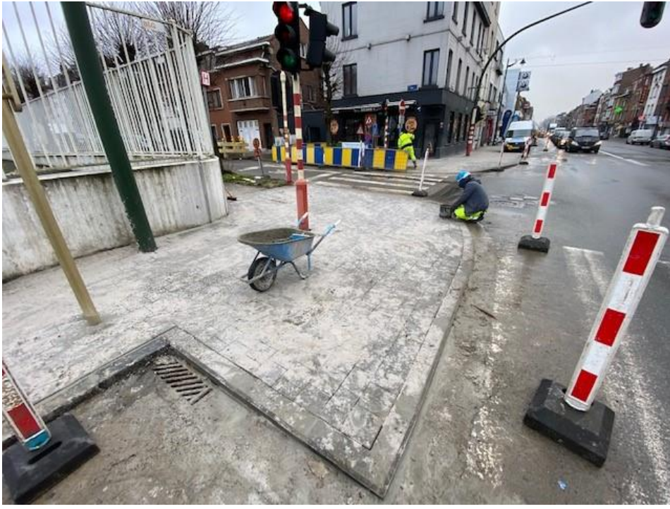
Chaussée de Ninove : nouvelle oreille de trottoir
