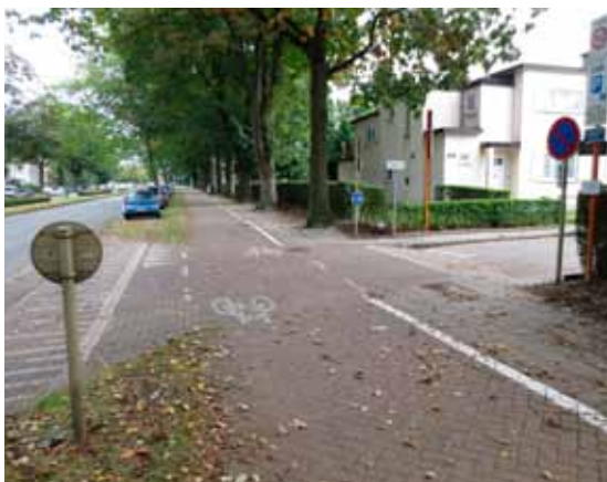
Fig.4.6. Het D9-fietspad loopt over het kruispunt als gemarkeerd fietspad op een plateau (Emile Vanderveldelaan x Claireaulaan). Het verkeer dat uit de bedieningsweg komt wordt tweemaal met een voorrangstreep geconfronteerd, eenmaal voor het fietspad en eenmaal erna. Voertuigen die voor de tweede voorrangstreep wachten beletten niet helemaal de doorgang op het fietspad.
