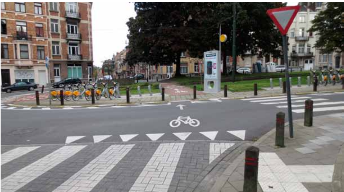
Fig. 4.27. Het autoverkeer dat rechtdoor moet rechts afslaan om naar het volgende kruispunt te rijden. De fietsers kunnen de berm en de tramsporen oversteken om rechtdoor te gaan (kruispunt Rogier x Marckelbach x Vanderbussche).
