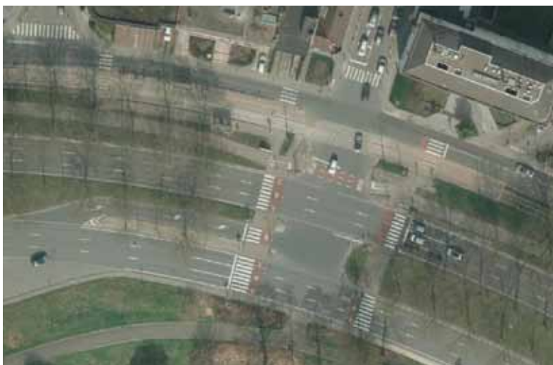
Fig. 5.27. Het tweerichtingsfietspad op de Tervurenlaan ter hoogte van de Troozlaan, beschikt over een conflictvrije lichtenregeling ten opzichte van de links afslaanende voertuigen. Het conflict met de voertuigen die op de Tervurenlaan in de richting van het centrum rijden en rechtsaf slaan is jammer genoeg nog steeds aanwezig alhoewel deze bestuurders een paar honderd meter voor het kruispunt al uitgenodigd worden om zich naar de ventweg te begeven.
