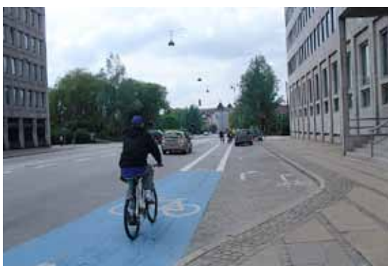
Fig. 5.12. CPH RA strook. Op dit kruispunt in Kopenhagen, worden de intenties van de fietser verduidelijkt door de markering, en het conflictpunt tussen de fietsers die rechtdoor rijden en de automobilisten wordt benadrukt door een gekleurde wegbekleding.
