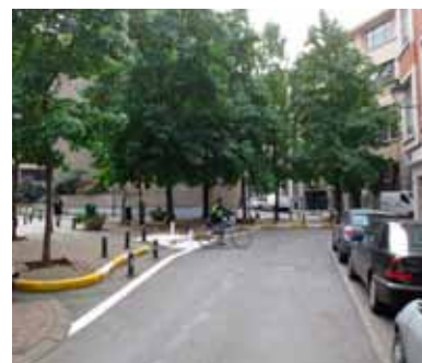
Fig. 3.8. Sint-Gillis: Bosquetstraat x Dejonckerstraat; de afgeschuinde boordsteen ter hoogte van de fietsersdoorsteek valt op door zijn witte markering
