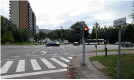
Fig. 5.5. Ingebogen VFP - Hof ten berg x Woluwelaan. De markeringen van de ondergeschikte weg lopen bij voorkeur niet door over het kruispunt. Een marking met sergeantsstrepen en fietslogo's wordt daarentegen aanbevolen als het traject dat de fietsers moeten volgen niet direct in het verlengde ligt van de weg die ze verlaten.
