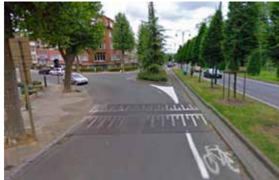
Figure 4.19. Verkeerseiland vuurkruisen. Dit laterale verkeerseiland draagt bij tot het afremmen van het verkeer op de ventweg (met eenrichtingsverkeer) en tot het afbakenen van het kruispunt. Een doorsteek laat de fietsers die in tegenrichting rijden toe hun weg rechtdoor verder te zetten. Het gevaar aan het einde van de doorsteek is beperkt vermits er geen voertuigen van links komen en er geen geparkeerde voertuigen zijn. Bron: maps.google.be
