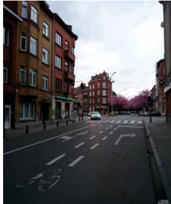
Fig. 5.35. Fos Rechtsafslagstrook. De rechtsafslagstrook bevindt zich rechts van het toeleidend fietspad van de OFOS. Omdat er iets voordien auto's geparkeerd staan moeten de fietsers de rijstrook niet kruisen om zich naar de OFOS te begeven. 's Avonds staan er meestal ook voertuigen geparkeerd op deze rechtsafslagstrook waardoor die haar functie verliest.
