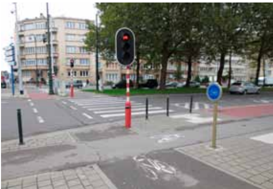
Fig. 5.18. De fietsers die rechtsaf willen slaan naar de Mettwielaan zijn niet onderworpen aan de verkeerslichten. Geleidetegels bakten het vrijliggend fietspad af. De markering van het voetpad zou moeten doorlopen over het fietspad.
