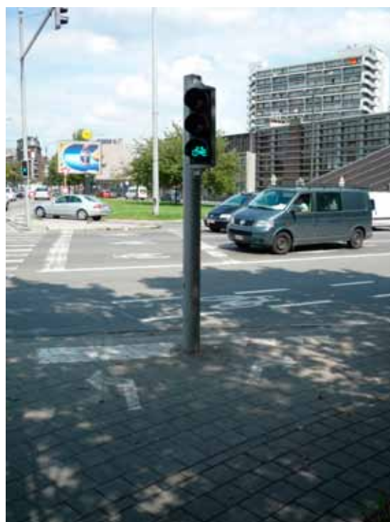
Fig. 5.16. Een pijl naar rechts en haaiantanden werden rechts van het verkeerslichtlicht aangebracht. Noot: de stopstreep mag niet worden aangebracht in afwezigheid van het bord B1. (Reders x Willebroek).
