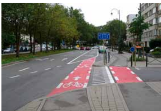
Fig. 5.8. Op de Mettwielaan, ter hoogte van de Ninoofsesteenweg, kunnen de fietsers kiezen tussen het vrijliggend fietspad of de voor fietsers opengestelde bijzondere overrijdbare bedding die er evenwijdig mee loopt en die ze naar de OFOS leidt waardoor ze in één beweging naar links kunnen afslaan.
