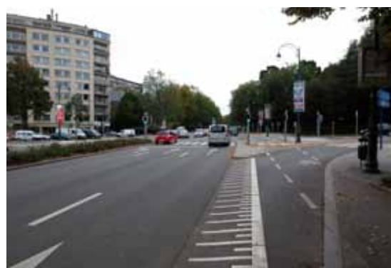
Fig. 5.13. Roosevelt-Lloyd. De bypass van het verkeerslicht is ingericht als plateau waardoor het verkeer het fietspad slechts kan kruisen aan een gematigde snelheid (kruispunt Roosevelt – Lloyd Georges).
