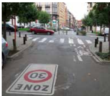
Fig. 3.7. Schaerbeek: Louis Bertrandlaan. De doorgang tussen de Jenatzy- en de Bijenkorfstraat is enkel opengesteld voor fiets- en voetgangersverkeer. Merk op dat het fietspad niet gemarkeerd hoeft te worden op het kruispunt.
