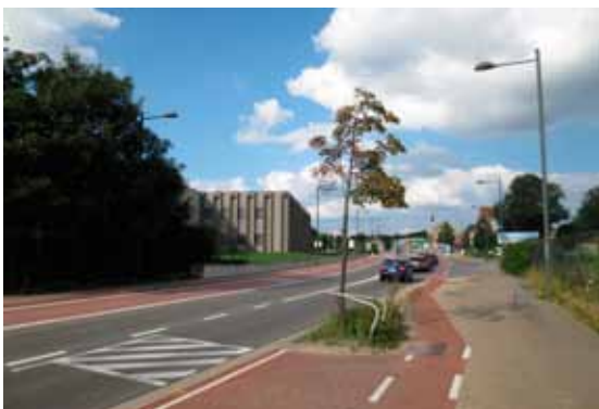
Fig. 5.2. Voor een goede zichtbaarheid van de rechts afslaande voertuigen, wordt het vrijliggend fietspad naar de rijbaan ingebogen en wordt het doorgetrokken over het kruispunt als een gemarkeerd fietspad (GFP). (Haachtsesteenweg).
