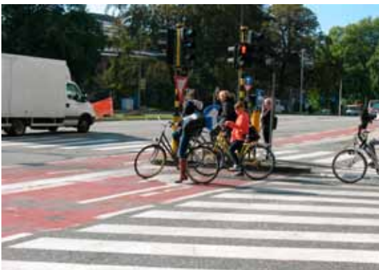
Fig. 5.41. et fig. 5.42. Indirect linksaf met specifiek verkeerslicht voor fietsers te Gent (Citadellaan).
