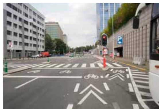
Fig. 5.15. Pachecolaan. De fietsers die rechtdoor rijden zijn niet onderworpen aan de verkeerslichten op hun linkerszijde. In dit geval zouden voorselectiepijlen voor de fietsers nuttig zijn. De markering van de stopstreep rechts van het verkeerslicht hoort er niet te zijn
