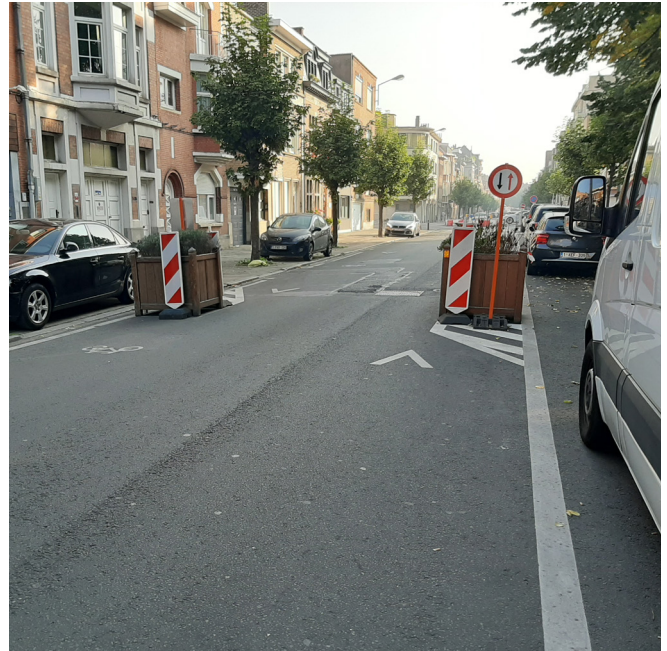
Figure 7 : Passage alterné avec des bacs à fleurs et marquages (Jette)
