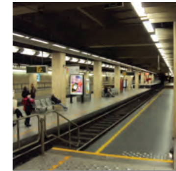
2000-2010 Photo du gauche: exemple d'un local technique dans une station, photo du centre: Station Bockstael 2012 (avant la rénovation); photo du bas: Station Bourse 2012. DITP BM
