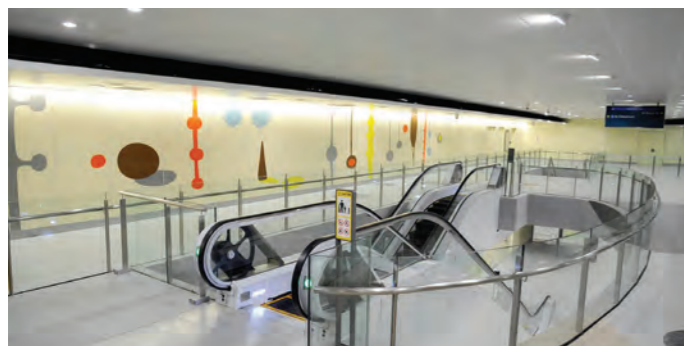
Telok Ayer station on Downtown Line Stage 1 Het station Telok Ayer op Downtown Line Stage 1 La station Telok Ayer sur la ligne Downtown phase 1
