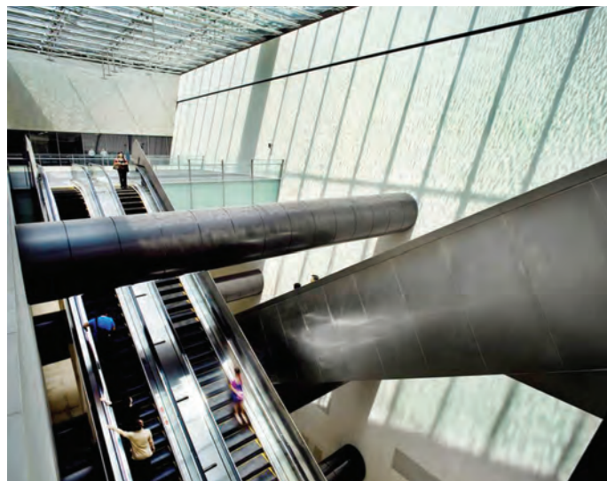
The same view in the finished station Hetzelfde beeld, in het afgewerkte station La même vue de la station achevée
