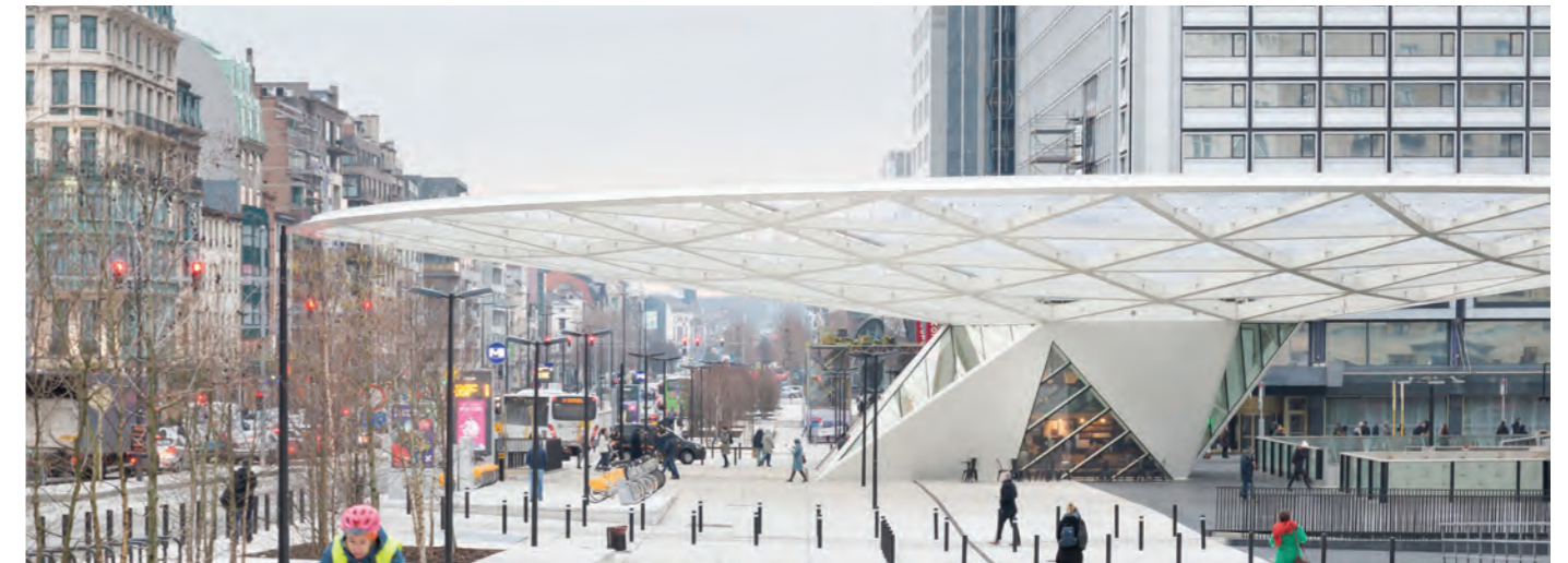
De luifel van het metrostation Rogier. Foto Matthias Van Rossen. XDGA
