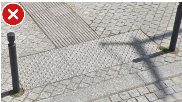
Les clous en inox sont à éviter en extérieur pour des questions d'adhérence et de contraste
