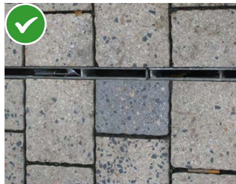
Caniveau à fente (max 2 cm)
