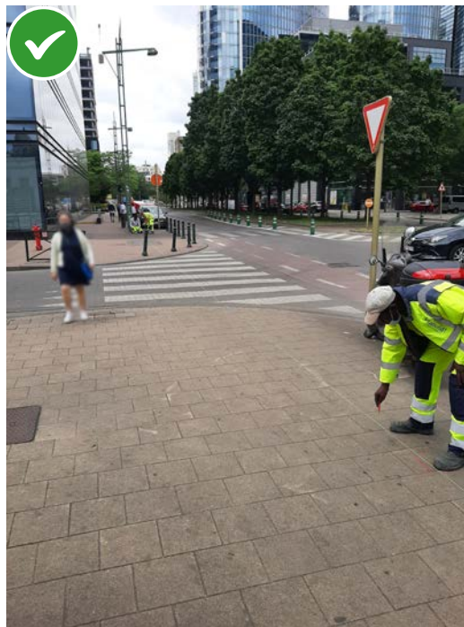
Utiliser une ficelle pour tracer au sol l'axe de la traversée
