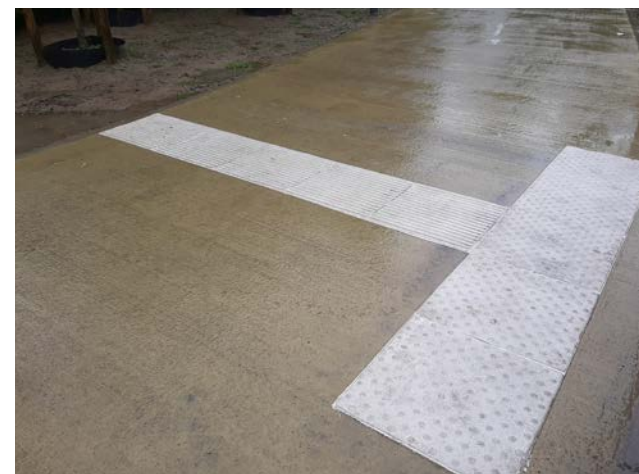
Revêtement podotactile préformé thermocollé
