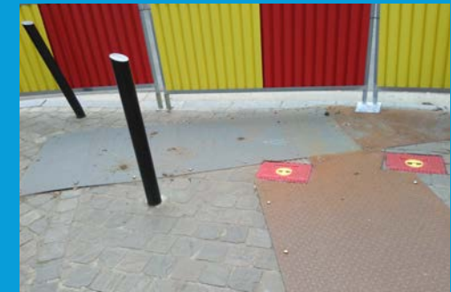
Revêtements podotactiles neutralisés temporairement par des plaques métalliques pendant un chantier
