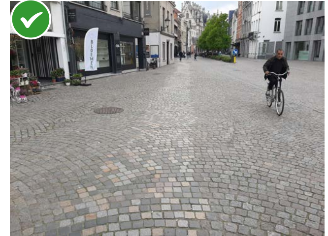
Traitement différencié d'une partie du revêtement offrant ainsi un cheminement confortable pour les piétons (Malines)
