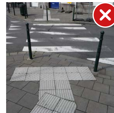
Le changement de direction des revêtements striés n'est pas matérialisé par des dalles souples, la ligne de guidage est trop courte (< 1 m 20) et des potelets sont présents dans l'axe des stries...
