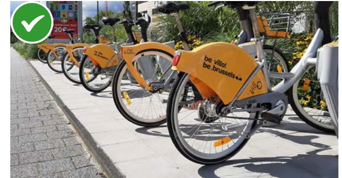
Stationnement Villo! placé le long de la ligne guide naturelle mais équipé d'une bordure de 5 cm détectable à la canne par une personne déficiente visuelle
