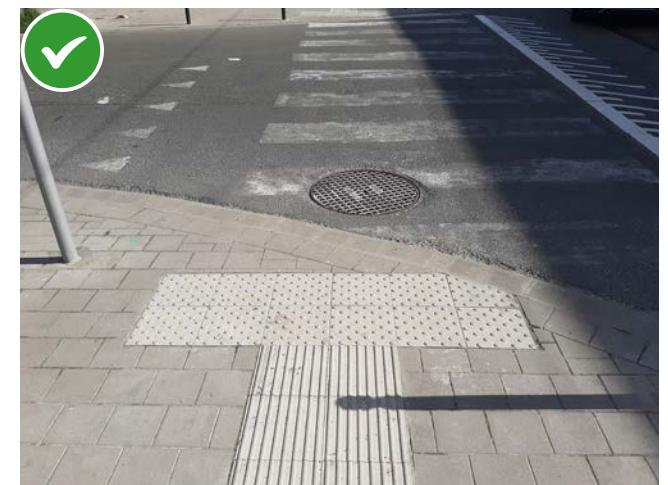
La première bande de dalles à protubérances est complète
