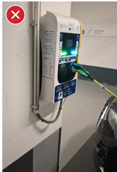
Borne murale inaccessible : prise située à 125cm du sol et zone d'information située à 135cm
