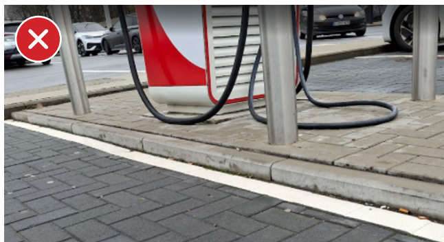
Borne inaccessible vu la différence de niveau avec l'emplacement
