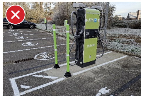
Parking d'une surface commerciale : 10 emplacements pour la recharge mais aucun accessible
