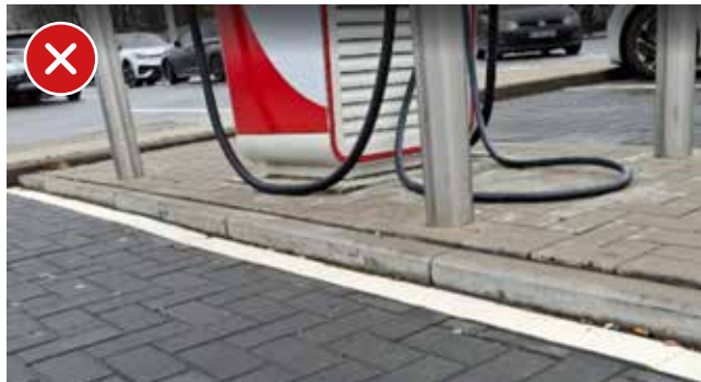
Laadpaal is ontoegankelijk door het niveauverschil met de parkeerplaats
