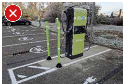
Parking van een winkelcentrum: 10 laadplaatsen, maar geen enkele toegankelijk voor PMH's
