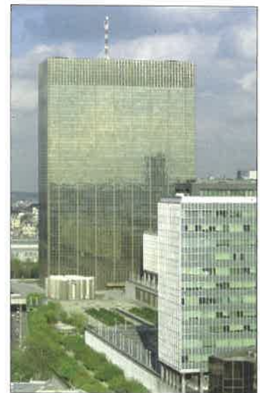
Secteur tertiaire de décision en plein centre-ville.
